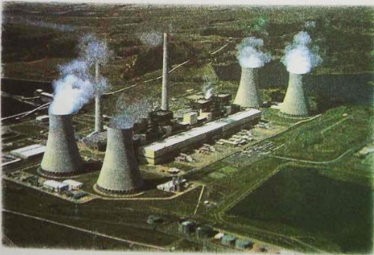
محطة نووية لتوليد الطاقة الكهربائية
